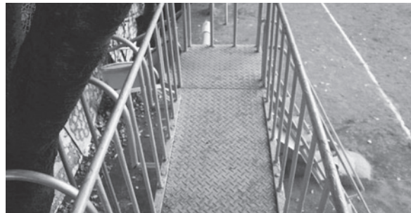
写真2 遊具上部の鉄板と両面の柵。写真左にのぼり棒が一部見える。
