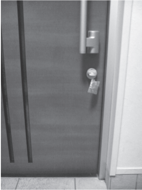
写真1 ドアの取っ手の下部分にフードが引っかけた。地面から取っ手下部までの高さは67cmであった。
